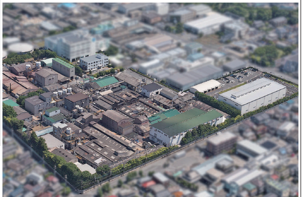
機能性磁性粉メーカー、パウダーテックの柏工場。LPガスフォークリフト30台が24時間体制の操業を支える
